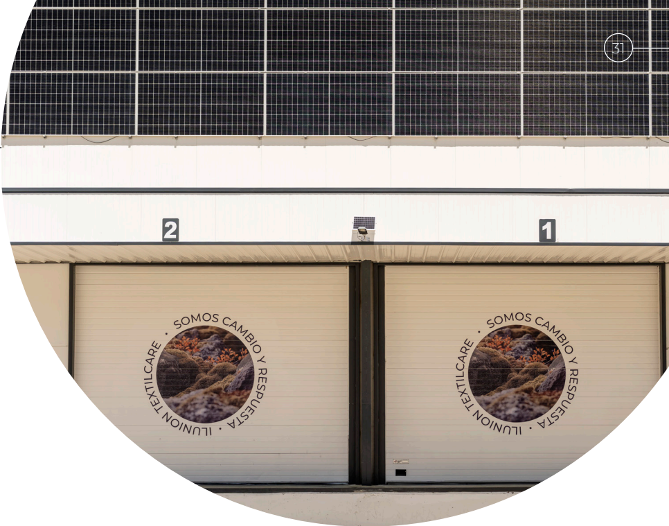
Fachada con placas solares de nuestra planta de Sevilla Sur
