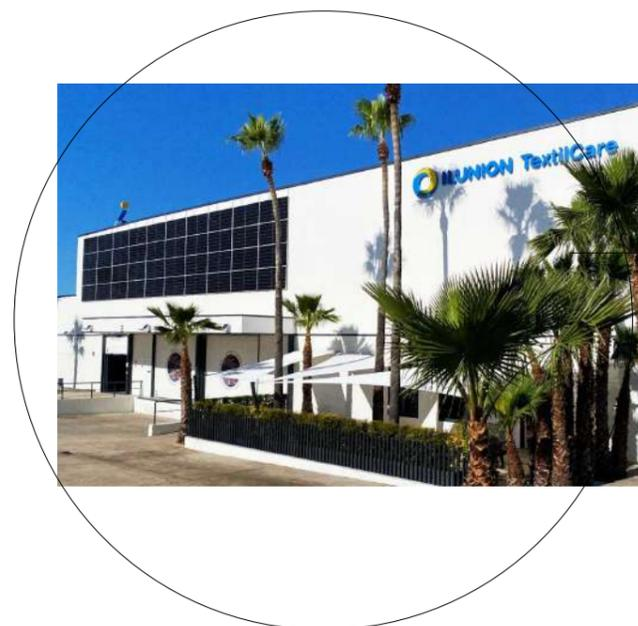
Placas fotovoltaicas en la fachada de la planta de Sevilla Sur
